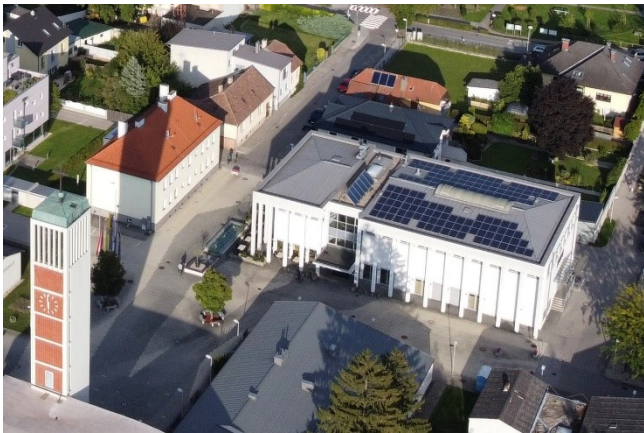
Hier sieht man die 40kW PV-Anlage, die vor drei Jahren am Dach des Gemeindezentrums installiert wurde. Sie versorgt das Gemeindezentrum mit nachhaltiger und erneuerbarer Energie. (Foto: Mergim Januzi)
