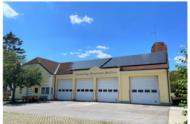
Die neue Photovoltaikanlage am Dach des Zeughauses wurde im Juni montiert und versorgt nun die Feuerwehr mit sauberem Strom.
