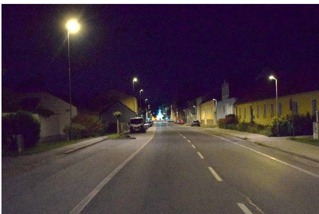
2020 wurde die öffentliche Beleuchtung auf LED umgestellt. Die neuen Leuchtmittel schaffen eine zeitgemäße Beleuchtung auf unseren Straßen.
