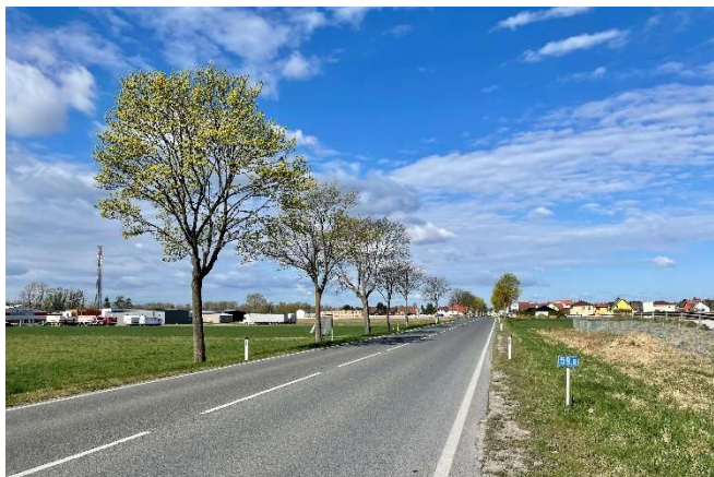
Heuer wird der Radweg Richtung Leobendorf/Korneuburg gebaut.
