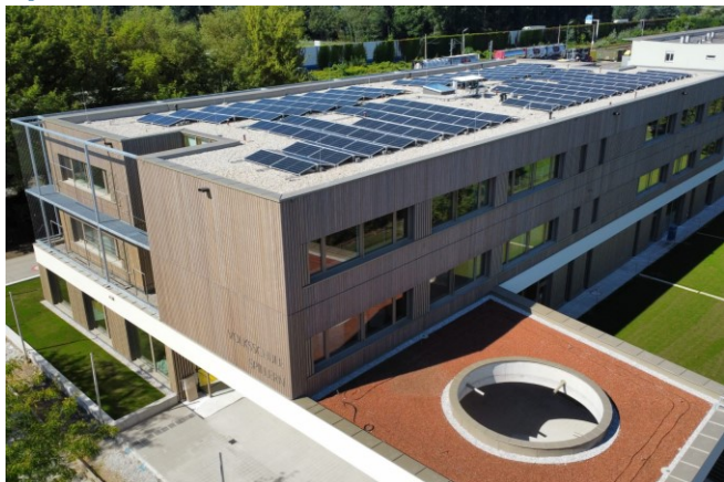
Die Photovoltaikanlage am Dach der neuen Volksschule ist mit einer Leistung von 110 kWp die größte PV-Anlage im Gemeindegebiet.
