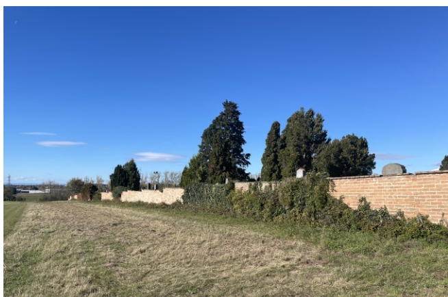
Im Frühjahr des nächsten Jahres entsteht hier ein Photovoltaikzaun. Die alte Friedhofsmauer ist leider eingebrochen und muss deshalb erneuert werden.
